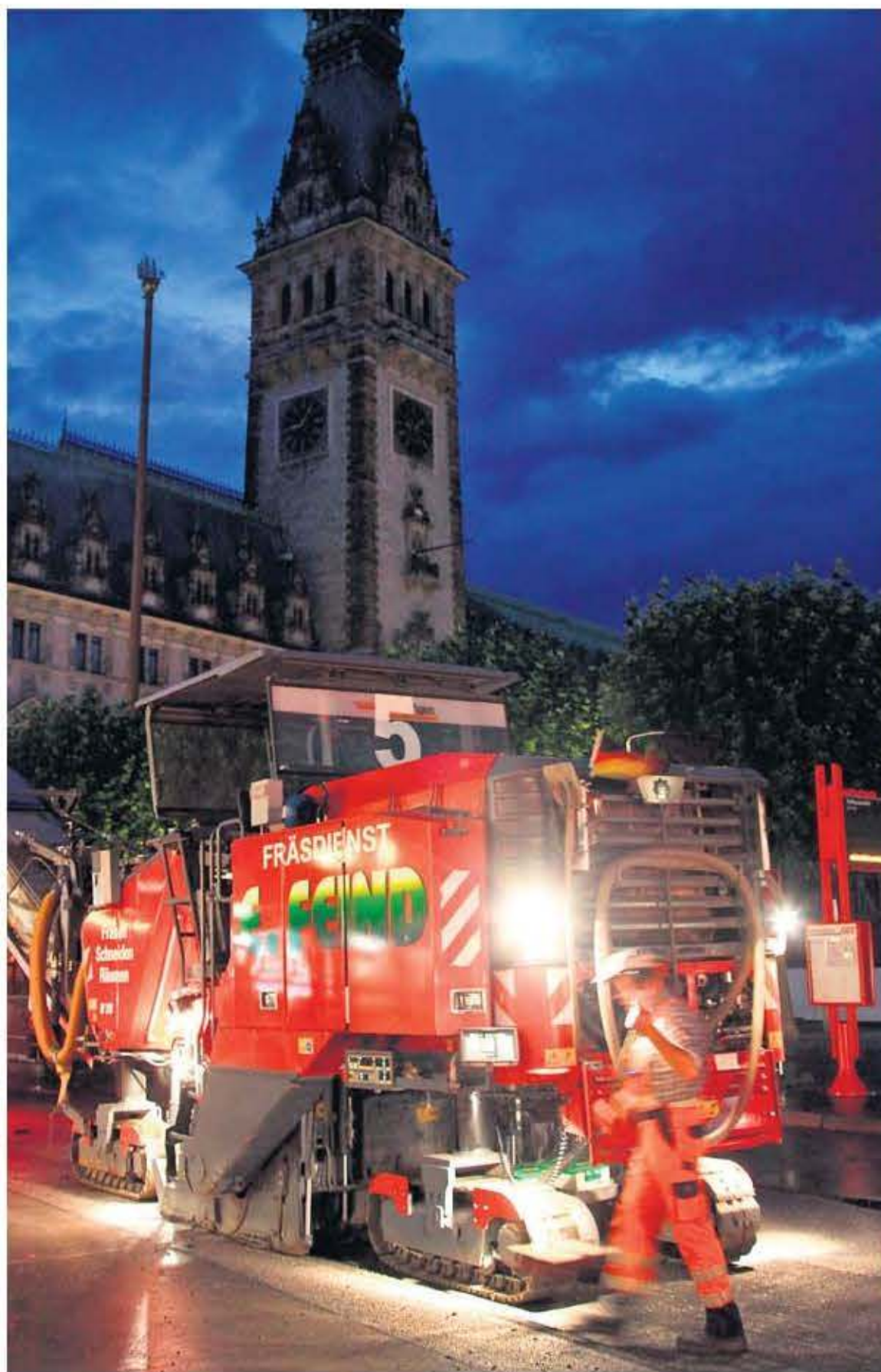
Noch in der Nacht begannen auf der Mönckebergstraße vor dem Rathaus die Asphaltierungsarbeiten mit dem recycelten Belag Foto: Ingo Röhrein
