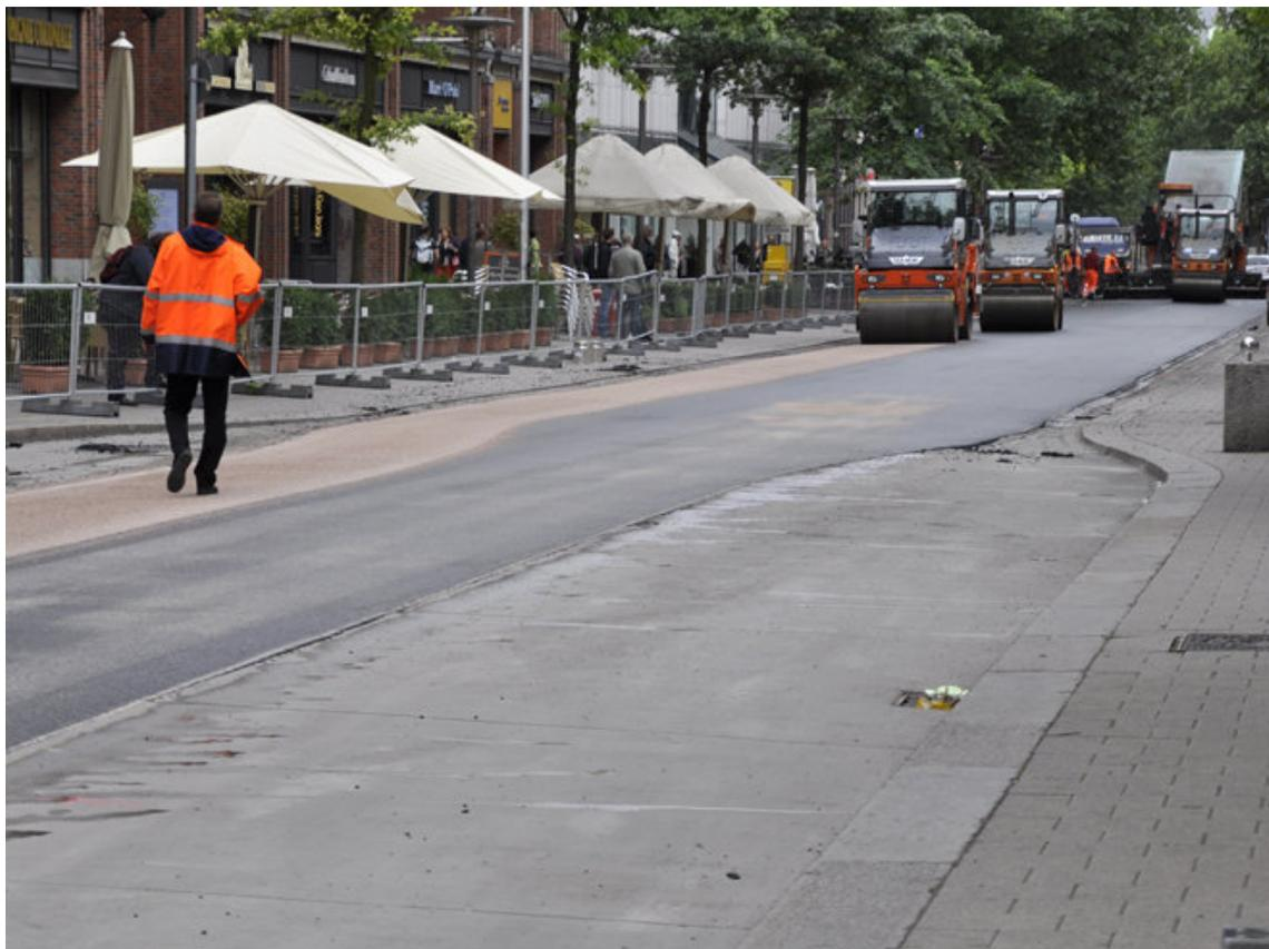
Hamburg recycelt die Mönckebergstraße: 500 Tonnen Asphalt wurden am Samstag den 25.08.2012 zwischen Hauptbahnhof und Rathaus abgefräst, über Nacht im Mischwerk aufbereitet und am Sonntag wieder eingebaut. Montagmorgen ab 5 Uhr soll der Verkehr wieder über eine neue Straße aus recyceltem Material rollen.
